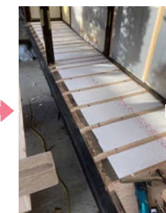
長い広縁にも断熱材を入れて縁の下からの外気をシャットアウト!
